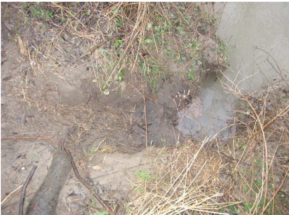
Rampe le long de la Rosselle, 30 décembre 2009
